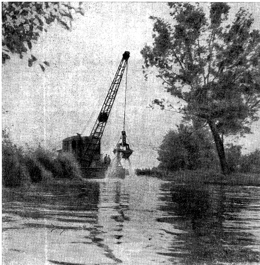
Пловучий экскаватор углубляет дно и расширяет берега маленькой речки Ипа, превращая ее в большой магистральный осушительный канал.
